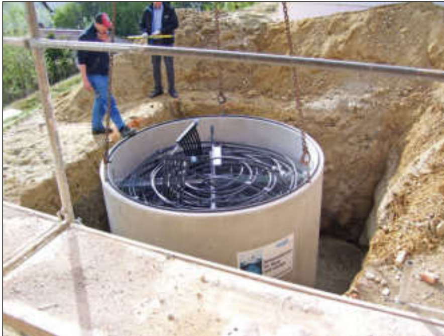
Abbildung 22: Betonzisterne ( d = 3,2 \text{ m} , h = 3,3 \text{ m} ) wird mittels Autokran in die fertige Grube gehoben (Bick, 2017; IKZ Haustechnik, 2017)
