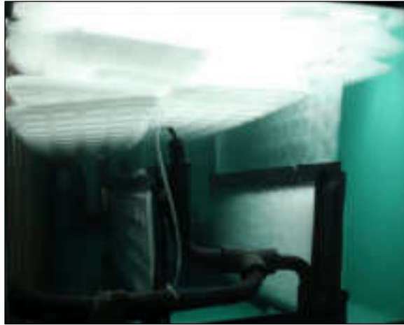
Abbildung 27: Aufgeschwommene Eisplatten nach Abtauvorgang und neue Eisplatten im Entstehen an den Wärmetauscher-Platten (SOLTOP Energie AG, 2024)
