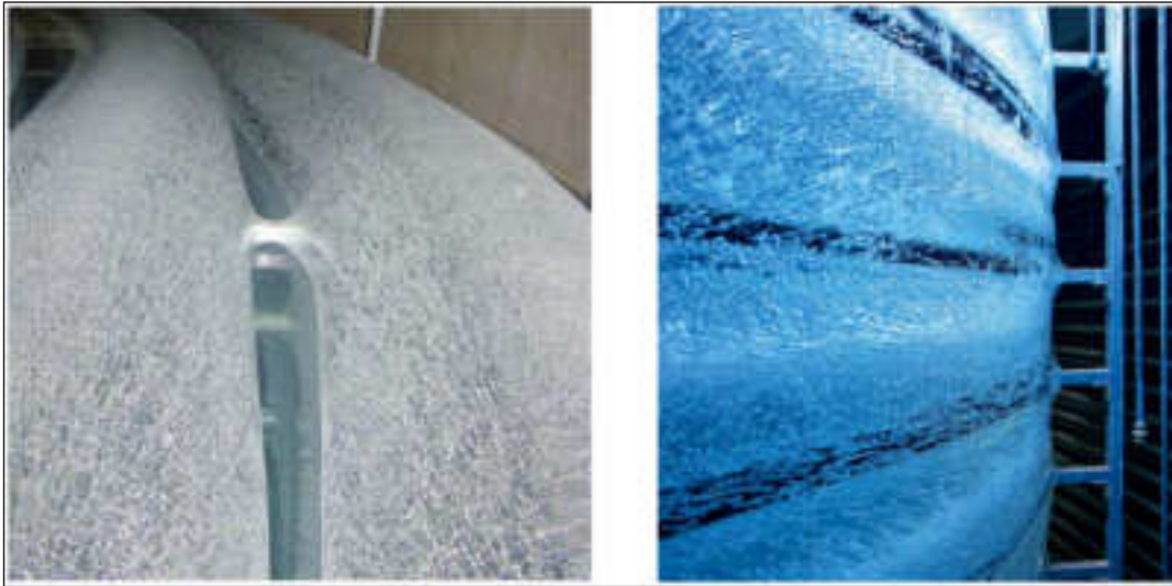
Abbildung 24: Seitenansicht eines durchgefrorenen Eisspeichers (Viessmann GmbH, 2022) (Viessmann GmbH, 2024)
