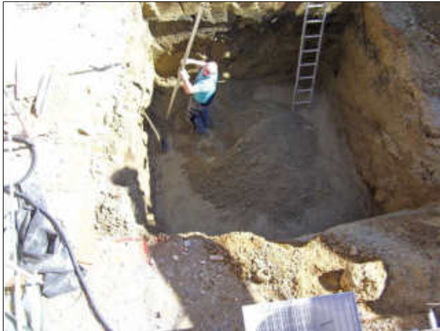
Abbildung 20: Das Ausheben der Grube für den 10 m 3 fassenden Eisspeicher im oberbayrischen Landshut. (Bick, 2017; IKZ Haustechnik, 2017)
