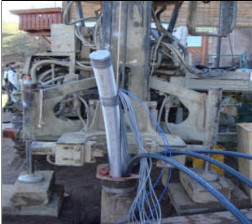
Abbildung 33: Oberes Ende des Erdwärmerohrs nach Einbringen in das Bohrloch (Kruse et al., 2011)
