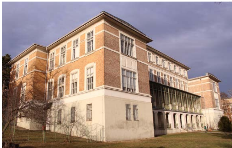
Abbildung 76: Musterpavillon Büro- und Universitätsnutzung - Pavillon 18 (Foto: LANG Consulting)
