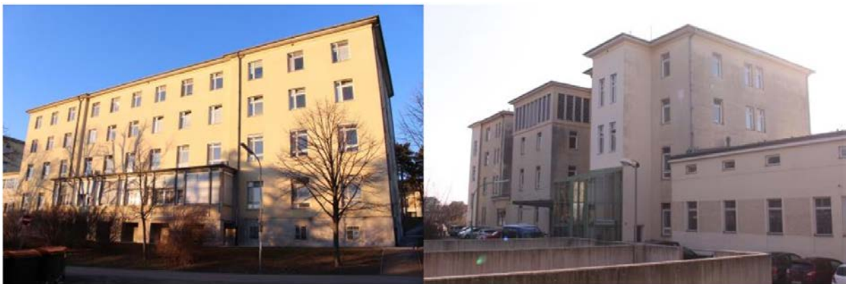
Abbildung 9: Beispielobjekt für Zone West, Pavillon Hermann (Südostseite, Nordwestseite) (Quelle: LANG consulting)
