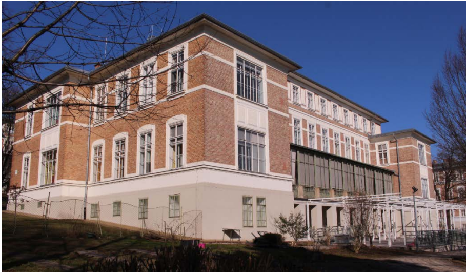
Abbildung 78: Musterpavillon Wohnnutzung - Pavillon 15 (Foto: LANG Consulting)
