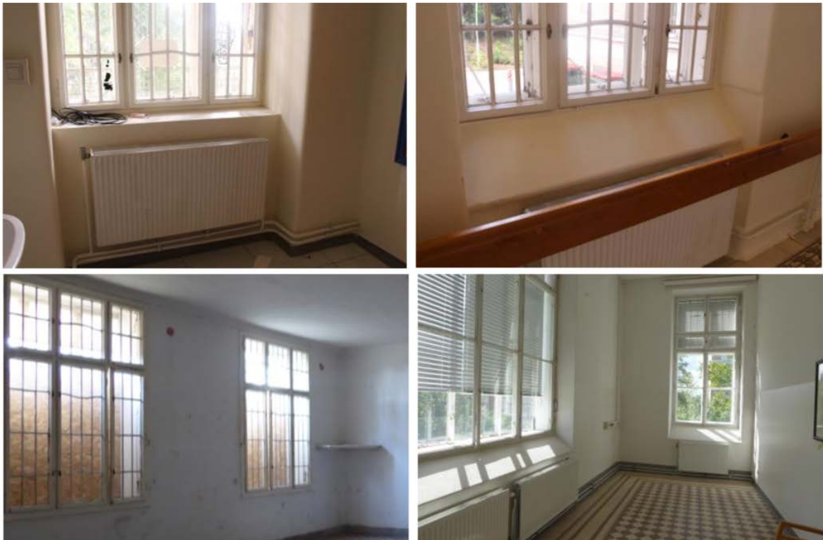
Abbildung 47: Beispiele für unterschiedliche Laibungen - Pavillon 4 (links), Pavillon 22 (rechts) (Quelle: LANG Consulting)
