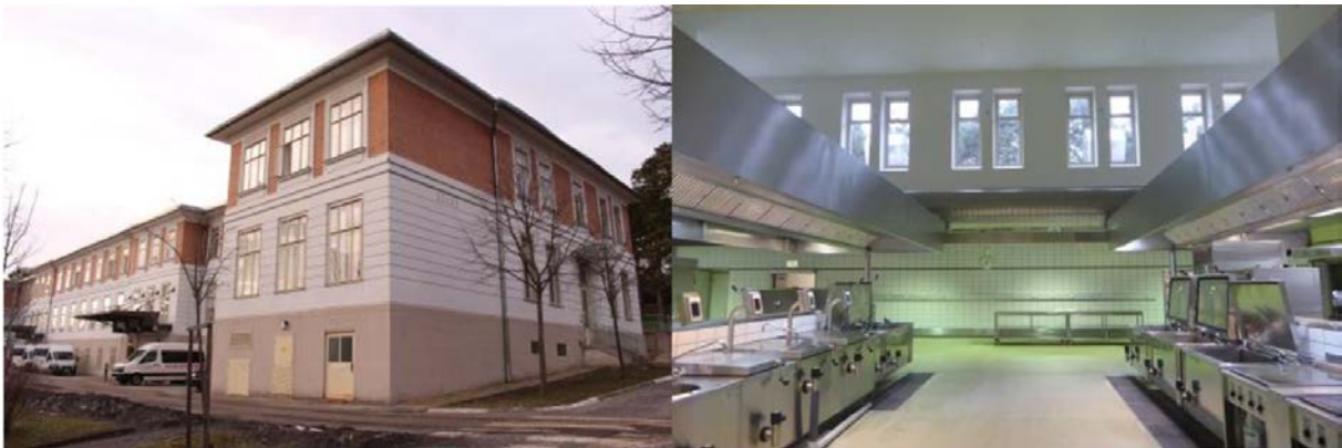
Abbildung 14: Beispielobjekt für Kernzone, Küche (Südostseite, Innenbereich) (Quelle: LANG consulting)
