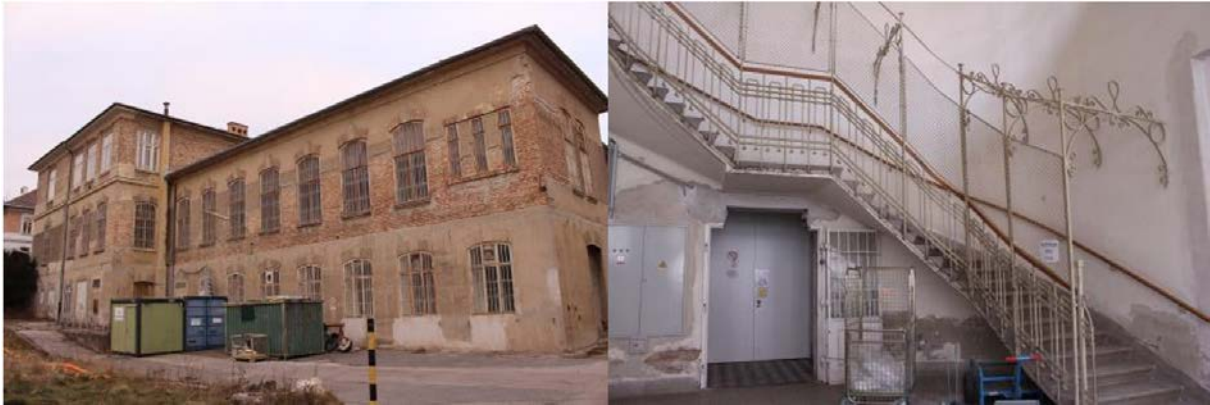
Abbildung 18: Beispielobjekt für Zone Ost, Wäscherei (Südostseite, Stiegenaufgang) (Quelle: LANG consulting)
