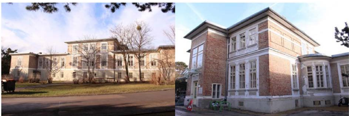
Abbildung 15: Beispielobjekt für Zone Ost, Pavillon 2 (Südseite, Nordwestseite) (Quelle: LANG consulting)
