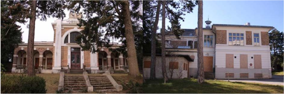
Abbildung 20: Beispielobjekt für Zone Ost, Pathologie (Ostseite, Nordseite) (Quelle: LANG consulting)
