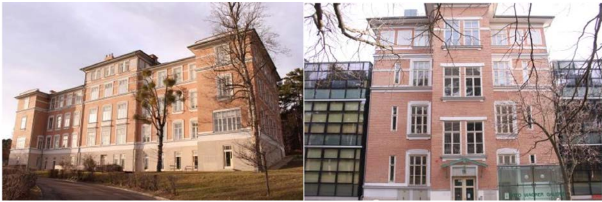
Abbildung 17: Beispielobjekt für Kernzone Ost, Pavillon 16 (Südostseite, Nordseite) (Quelle: LANG consulting)
