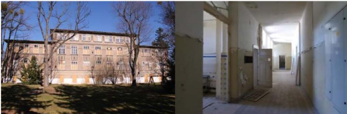
Abbildung 16: Beispielobjekt für Zone Ost, Pavillon 8 (Innen- und Außenzustand) (Quelle: LANG consulting)
