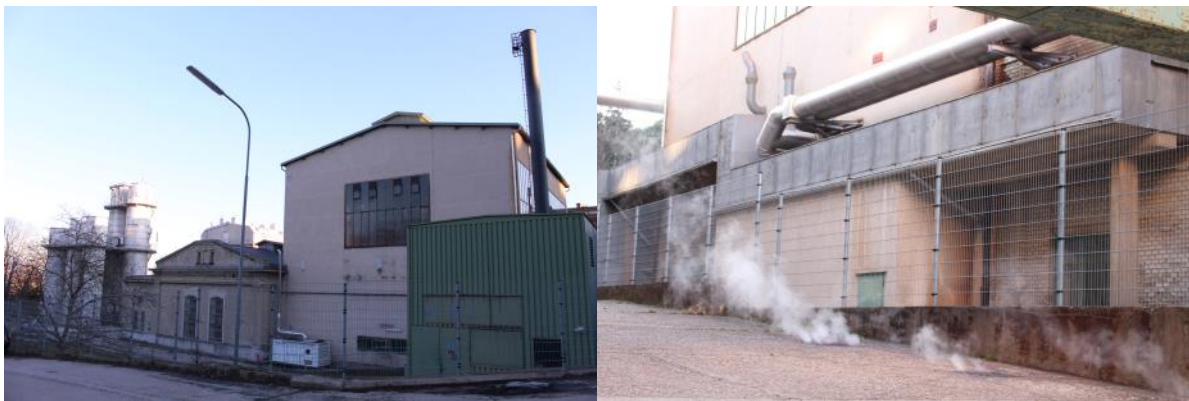
Abbildung 90: Altes und „neues“ Kesselhaus, Heißdampfaustritt (Foto: LANG consulting)
