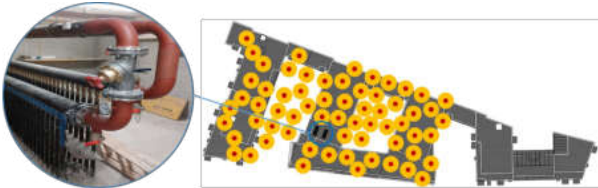
Abbildung 12: In einem eigenen Technikraum zusammengeführte noch ungedämmte Leitungen der Tiefensonden (links), Übersichtsplan mit der Lage der Tiefensonden (rechts) (Bildnachweis: Schöberl & Pöll GmbH)
