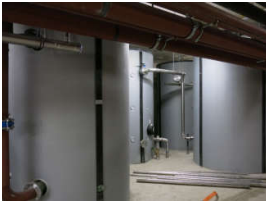
Abbildung 10: Technikraum mit Wärmespeichern (Bildnachweis: Schöberl & Pöll GmbH)
