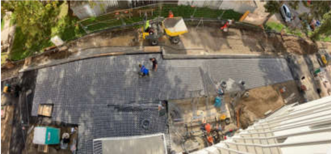
Abbildung 2: Errichtung des Asphaltkollektors in der Kätthe-Dorsch-Gasse 17, 1140 Wien (Bildnachweis: AIT)
