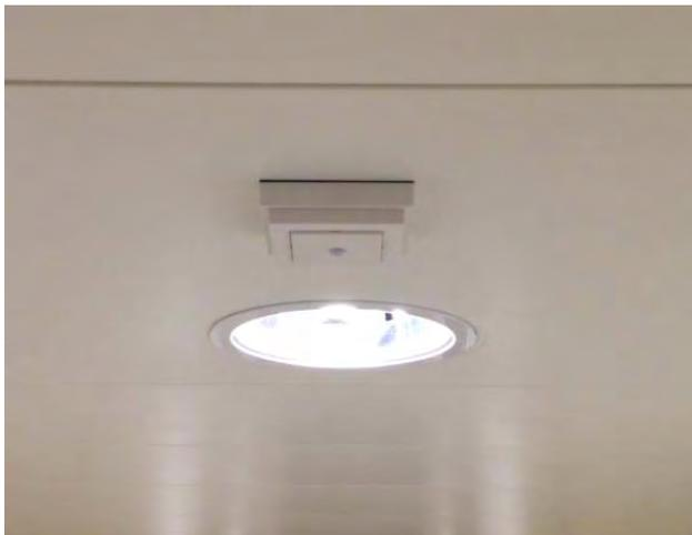
Abbildung 15: Erste Anwendung in einem Gangbereich zur Schaltung der Beleuchtung (Foto: Schöberl & Pöll GmbH)
