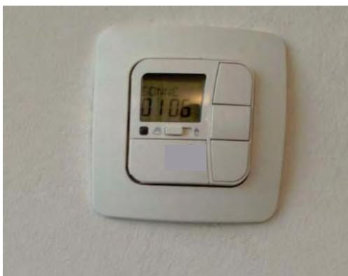
Abbildung 27: Sonnenschutzsteuerung (Foto: Schöberl & Pöll GmbH)
