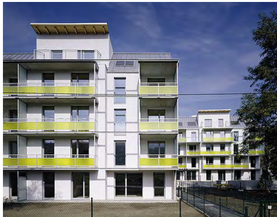
Abbildung 3: Außenansicht des Bauprojekts 'Utendorfgasse' [Bruno Klomfar]
