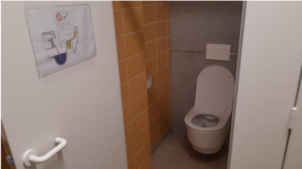
Abbildung 3: Eine der beiden installierten Trenntoiletten am Standort Gmunden der Fa. Laufen. An der Innenseite der Tür ist ein Informationsblatt mit einer Prinzipskizze der Toilette und einer „Benutzungsanleitung“ angebracht (Bildnachweis: Institut für Umweltbiotechnologie, BOKU Wien)
