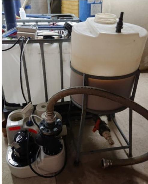
Abbildung 4: Sammlung der Braunwasserfraktion am Standort Gmunden der Fa. Laufen. Links hinten zwei IBC-Sammeltanks, rechts vorne ein Absetzbehälter (Bildnachweis: Institut für Umweltbiotechnologie, BOKU Wien)
