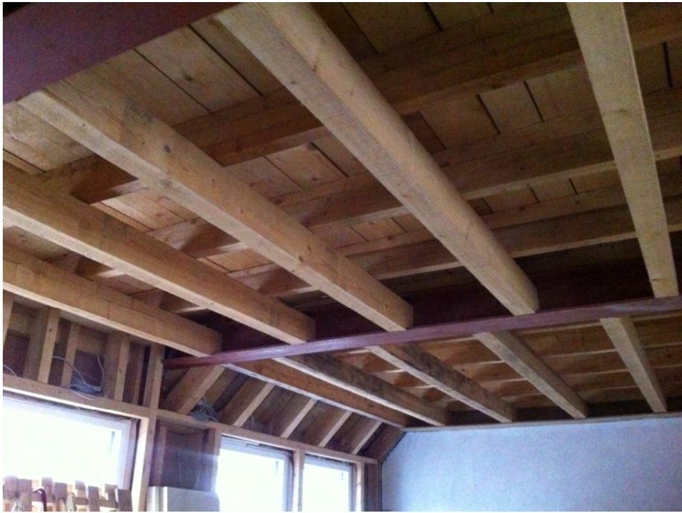
Abbildung 19: doppelschalige Holzkonstruktion zwischen Stahlträgern [Schöberl & Pöll GmbH]
