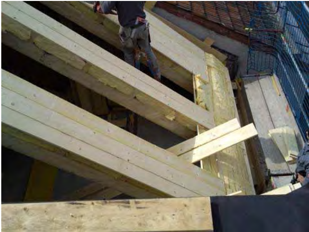
Abbildung 27: Holzschalung auf der doppelschaligen Schrägdachkonstruktion [ZIL10]
