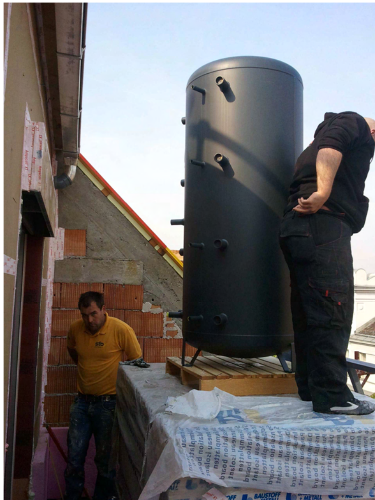
Abbildung 30: Lieferung des Pufferspeichers [Schöberl & Pöll GmbH]
