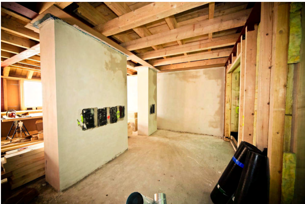
Abbildung 18: verputzte Kamingruppe ohne Vorsatzschale um die Speichermasse zu erhöhen [Schöberl & Pöll GmbH]
