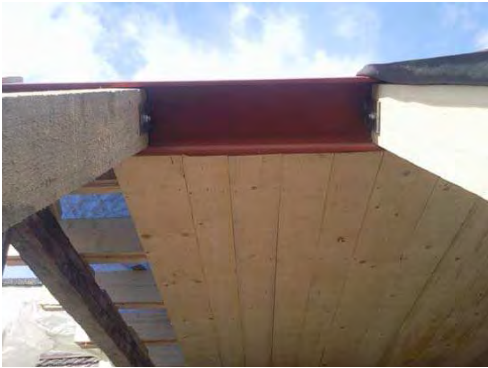
Abbildung 21: Anschluss der Holzträger an die Stahlträger [ZIL10]
