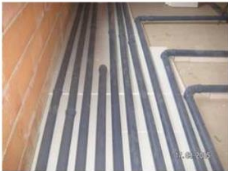
Starre Luftleitungen im Bodenaufbau (Quelle Poloplast)
