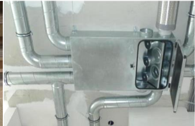
Abbildung 30: Kombinierte Verteilbox für Zu- und Abluft zur Auskreuzung von Luftleitungen (Quelle: leit-wolf Luftkomfort)
