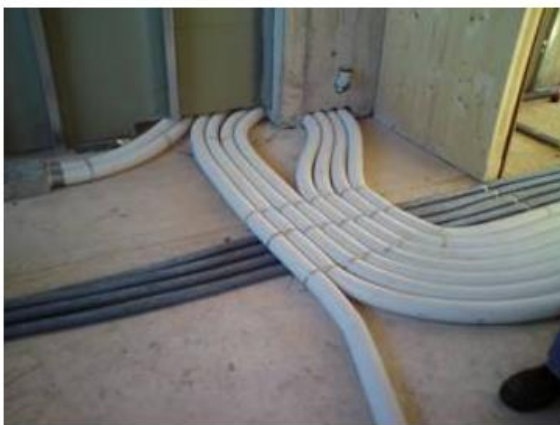
Flexible Luftleitungen im Fußbodenaufbau
