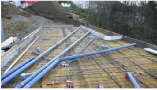
Starre Luftleitungen in der Betondecke (Quelle: Poloplast zw. SM-Heag)
