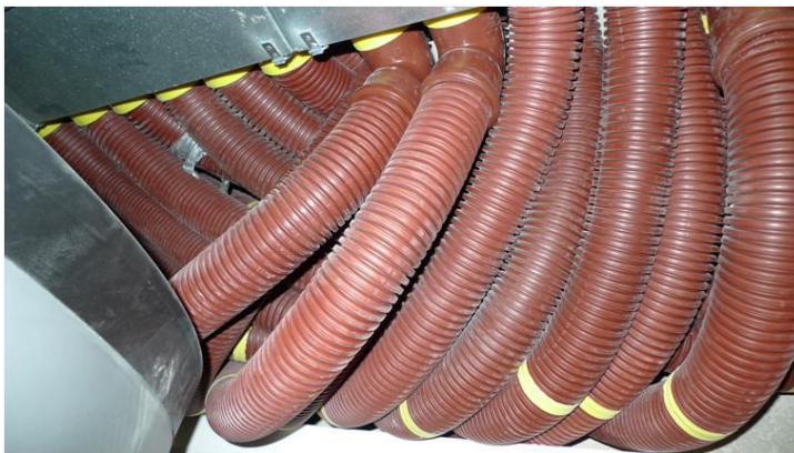
Abbildung 44: große Schlauchbündel nach Verteilbox (Leitzinger, 2013)
